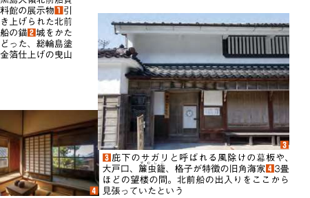
3 庇下のサガリと呼ばれる風除けの幕板や、大戸口、簾虫籠、格子が特徴の旧角海家 4 3畳ほどの望楼の間。北前船の出入りをここから見張っていたという
