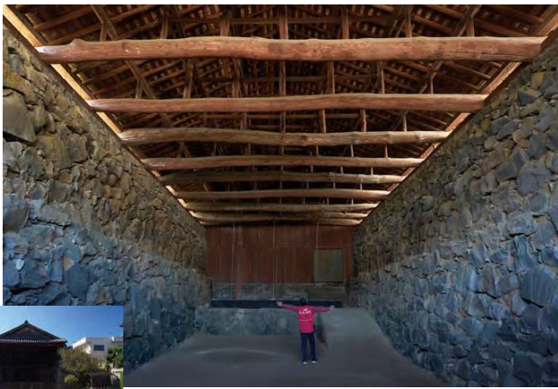
国指定史跡の旧萩藩御船倉。奥行26.9m、高さと間口各8.8m。両側に石垣を組み、その上に太い梁が、現在底部部分は埋め立てられている
