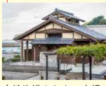
太地漁港ふれあい広場の立派な公衆トイレ
